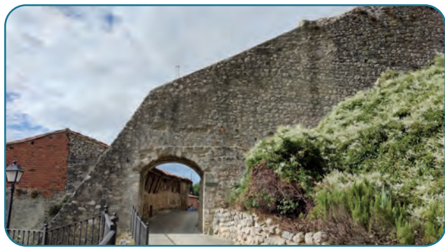
Vista actual de la muralla de Pancorbo
