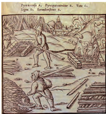
Fig. 21. Calcínación de piritas auríferas en Turingia (Alemania) según Agricola ( De Re Metallica , VIII)
