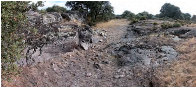
Fig. 13. Vista general de la trinchera de la Peña Los Caballos
